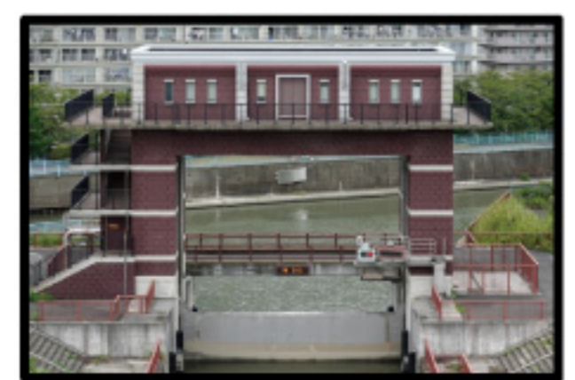
荒川ロックゲート
